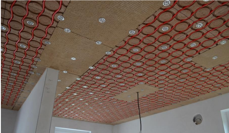
Vollflächige Deckenbelegung mit HochLeistungsLehm-Modulen und Lehm-Neutralplatten. Anbindung zum Heizkreisverteiler über die Flurdecke.
