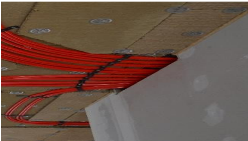
Niveaugleiche Anbindung durch Verwendung von Systemanschlussplatten als Putzträger.
