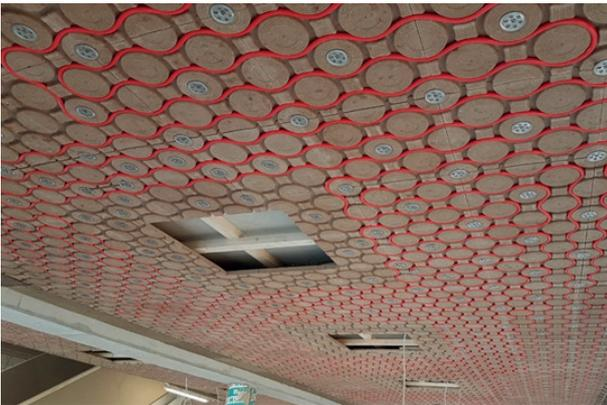
Befestigung mit Unterbauschalung und diversen Deckenauslässen
