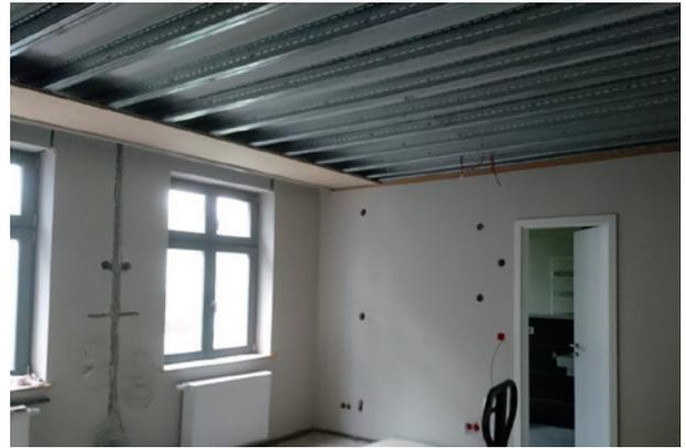
Einsatz von Weitspannträger als freitragende Deckenkonstruktion zur deutlichen Reduzierung des Trittschalls
