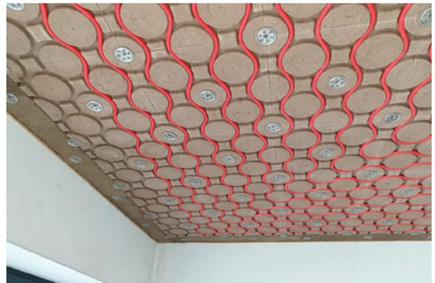
Kombination HLL-Modulen und Neutralplatten nach Rohrverlegung
