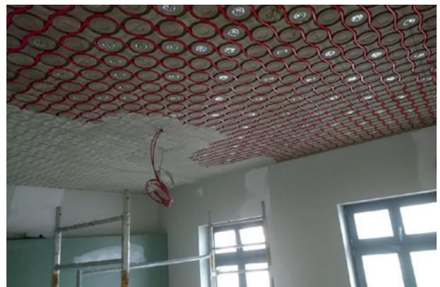
Druckvolles Auffüllen der HLL-Module, Fugen und Stöße mit Naturkalk-Grundputz HP 66-20
