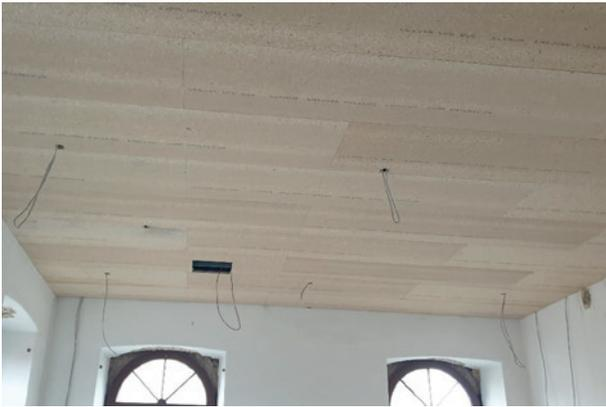
Unterkonstruktion aus 22mm OSB- oder ESB-Platten mit diversen Deckendurchführungen
