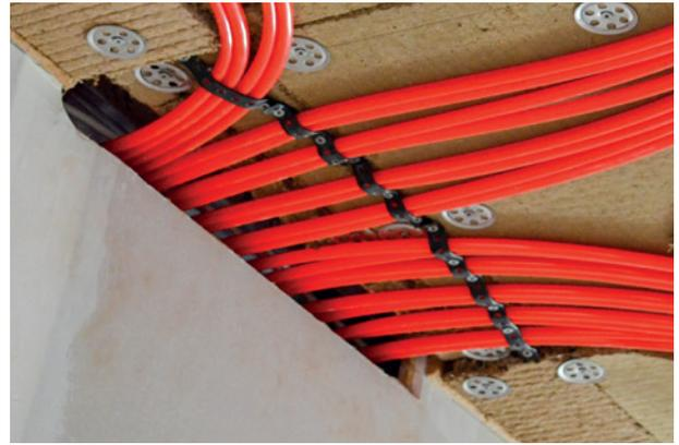
Niveaugleiche Anbindung durch Verwendung von Systemanschlussplatten, Rohrbefestigung mit Edelstahl-Lochband. **Wichtig:** Achten Sie darauf, dass der lichte Abstand zwischen den Rohren min. 1,5 cm beträgt, um so eine gute Putzhaftung zu gewährleisten.
